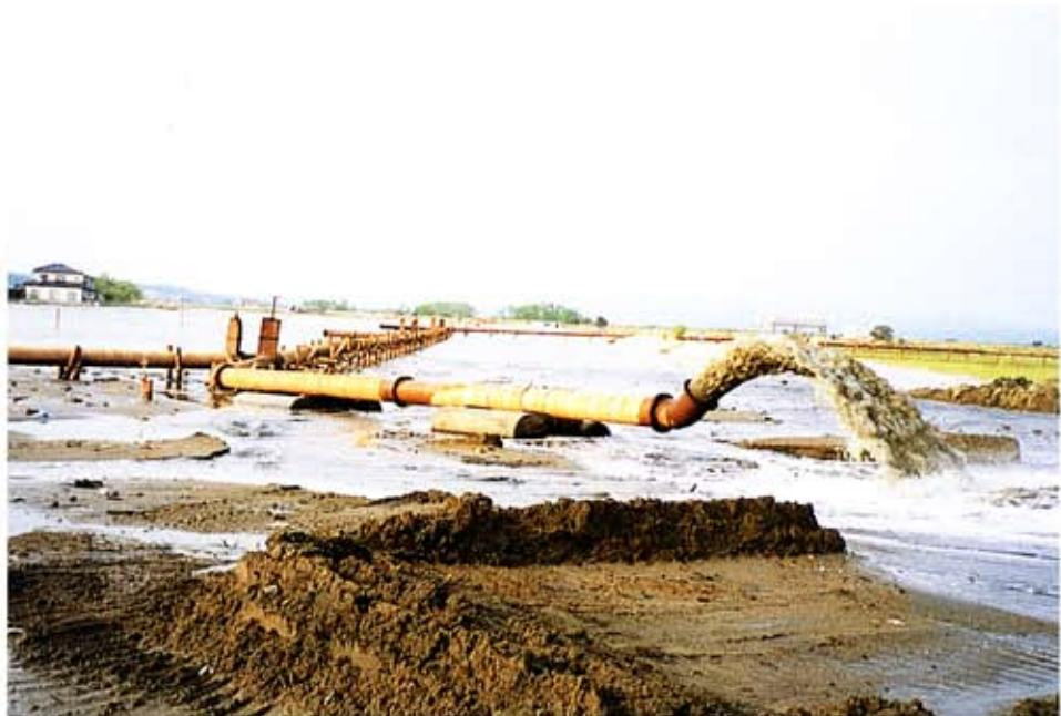
浚渫工事による排泥管の吹出口
