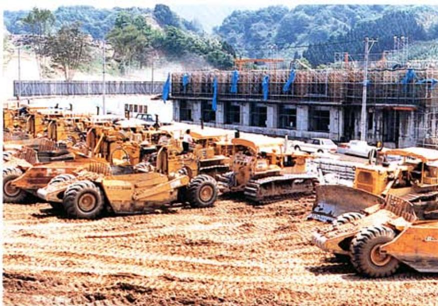
金沢大学移転工事に、常時フル稼動していたブルドーザーと、キャリアスクリューバー群。
