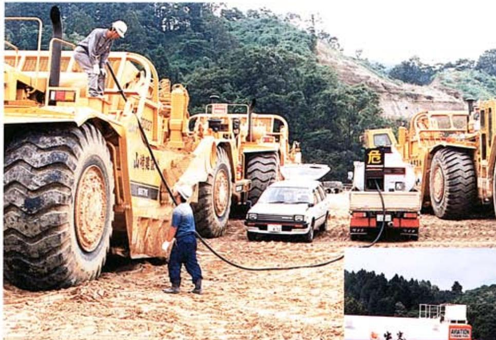
昭和63年5月、金沢大学角間町移転大造成工事に伴う、ブルドーザー、キャリアスクリューバーに給油する灯油燃料使用量は、一日約10,000 ℥ 使用。最盛期には、一日30,000 ℥ の燃料を使用していた。手取川生コンの社員も常時3~4人、臨時パートで頑張ってもらっていた。
