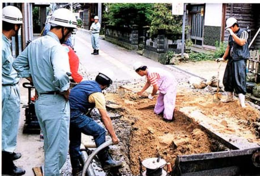
上下水道配管埋設工事には、特に土留鉄板等、破損・不備な箇所がないかチェックし、また指摘改善するよう勧める
