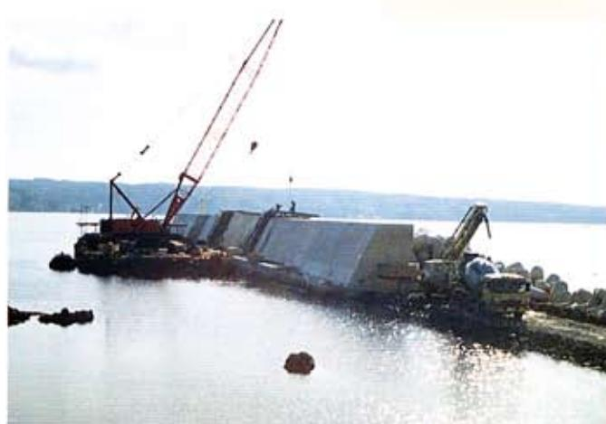
台船上クレーンによる上部工生コン打設状況
